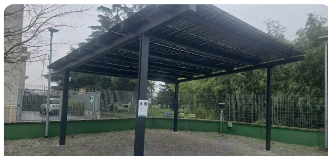
Struttura in alluminio con grondaia integrata (foto GoodWe)
