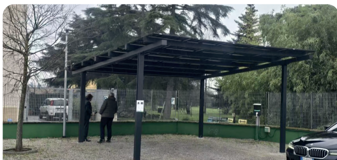
Vela installato in Italia (foto GoodWe)
